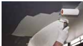
Nanesite antifauling povrh temelja.
