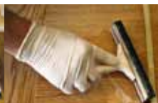
Uklanjanje onečišćene vode
