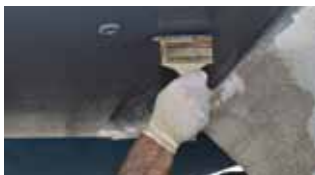
Kistom razvucite High Protect u suprotnom pravcu
