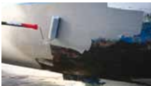
Na pripremljenu površinu nanosite Underwater Primer .
